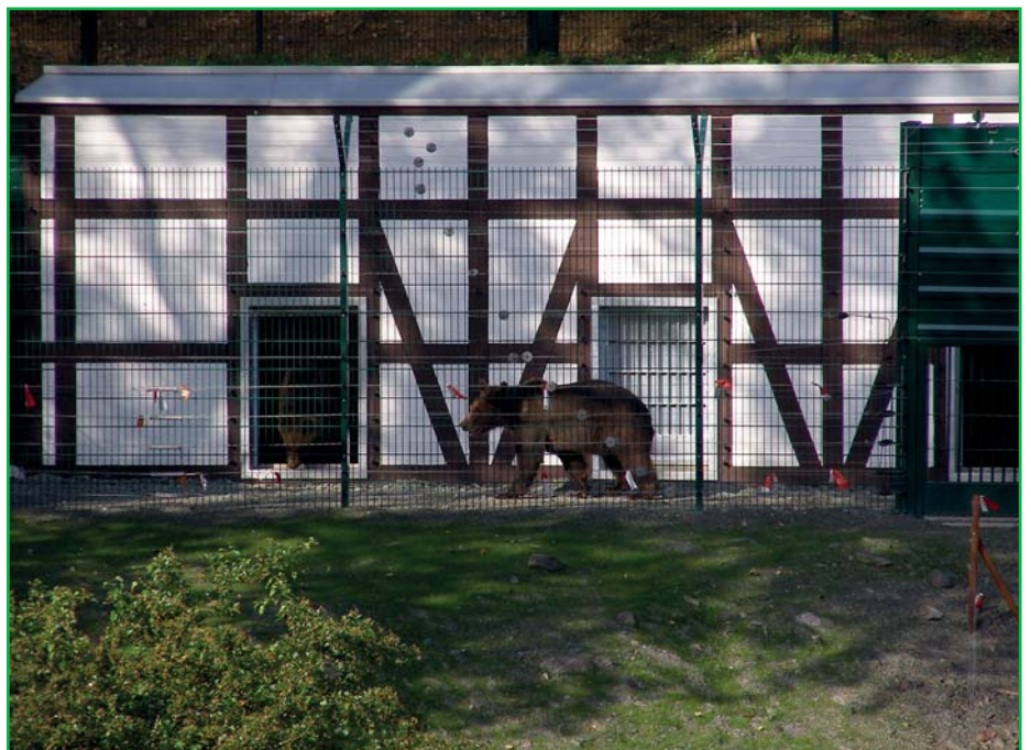
Das Bärenhaus im Wildpark Weilburg, mit traditionell orientierter Fachwerkfassade, jedoch mit Flachdach.
